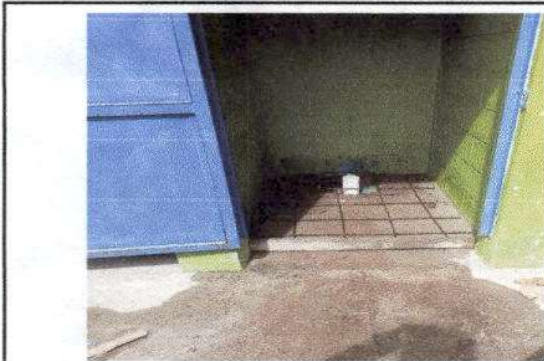
Foto 3: Lijado de puertas de baño y aplicación de pintura.
