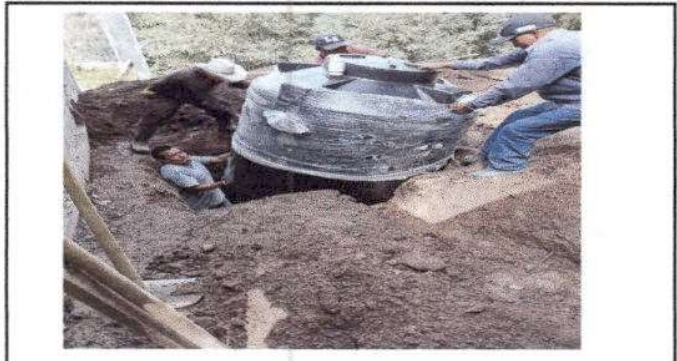
Foto 10: Instalacion de biodigestor
