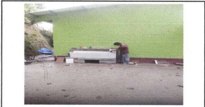
Foto 11: Realizacion de lavamanos de tres chorros
