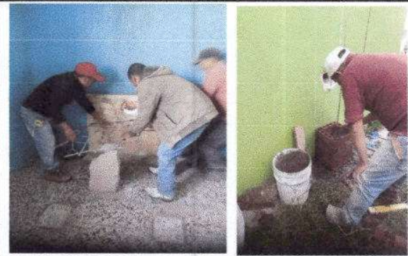
Foto 2: Realización de chimenea
