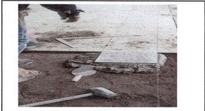
Foto 7: Cambio de piso de granito de bodega
