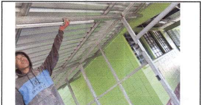
Foto 10: Cambio de sistema eléctrico de bodega
