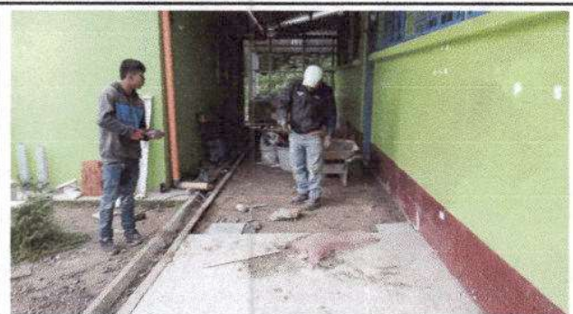
Foto 6: Realizacion de piso de granito de corredor
