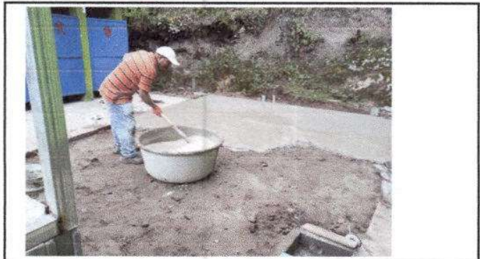
Foto 8: Realizacion de planta de concreto de patio
